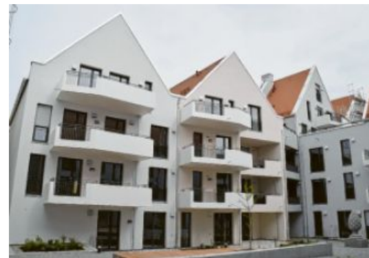
Das Neubauprojekt in der Georgenstraße bietet Platz für rund 170 Menschen.
